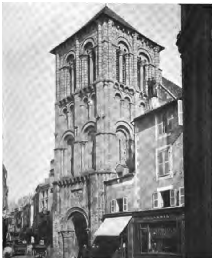
Fig. 48. — Grand clocher à plusieurs étages couvert par une charpente à l'église Saint-Porchaire de Poitiers. XII e siècle.
